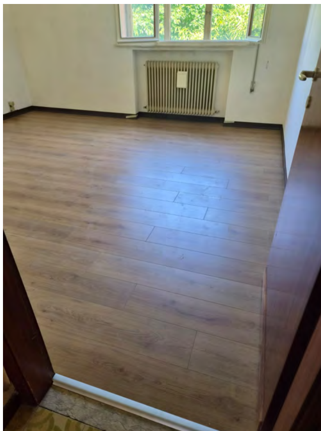
Foto 3 - vista pavimentazione camera lato nord-est dopo il confinamento
