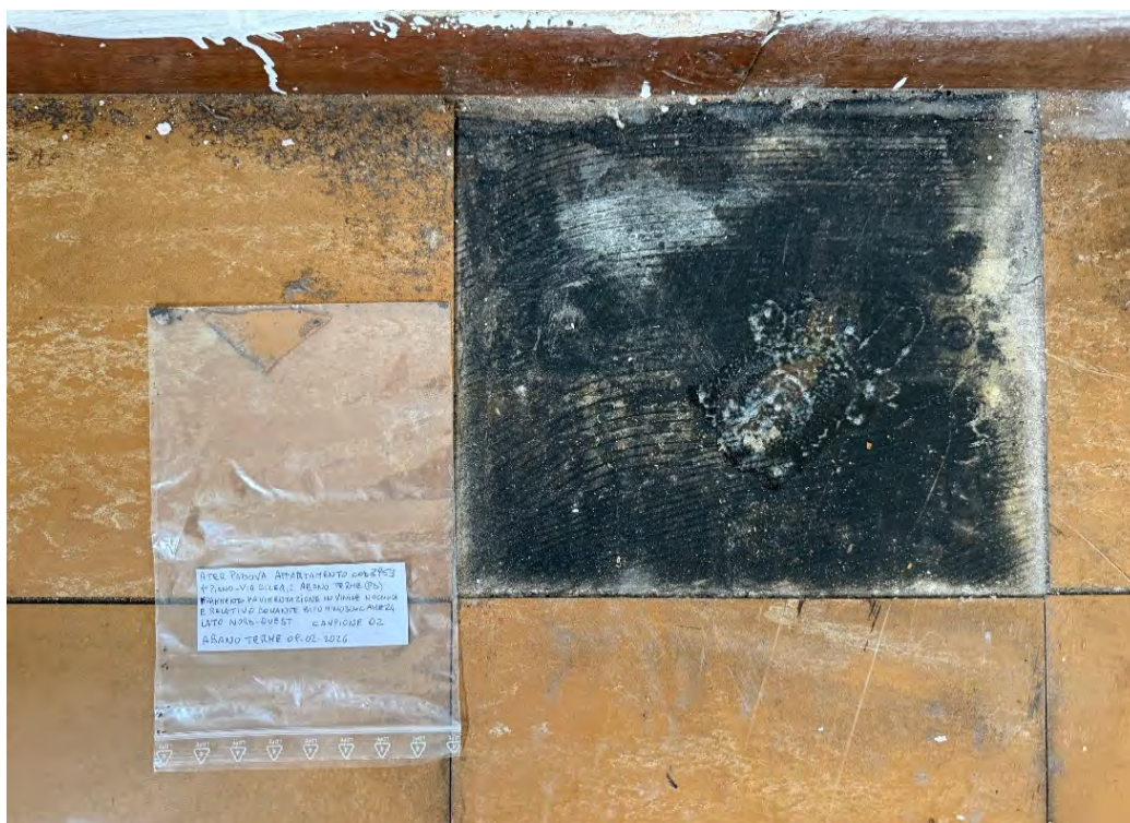
Foto 5 - campione 02 pavimentazione in vinile colore nocciola e collante bituminoso - camera lato nord-ovest
