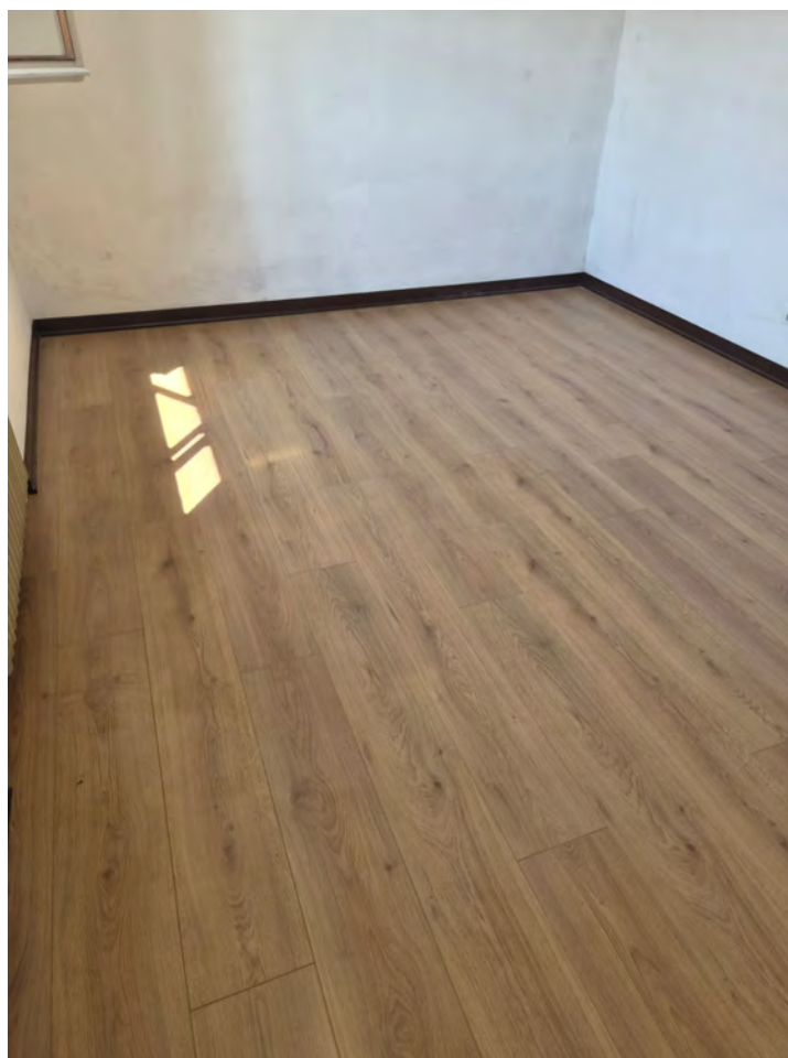
Foto 6 - vista pavimentazione camera lato nord-ovest dopo il confinamento
