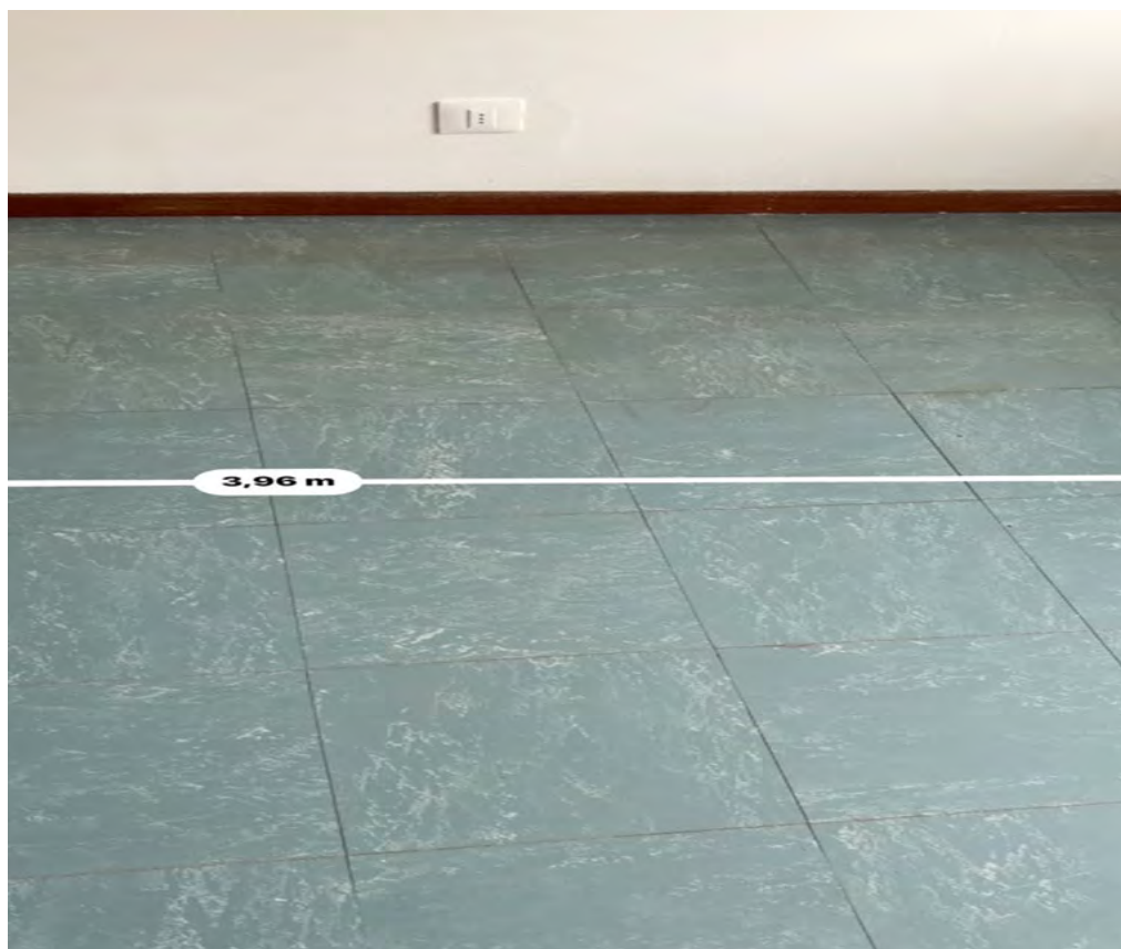
Foto 7 - vista pavimento in mattonelle viniliche colore azzurro – stanza lato ovest
