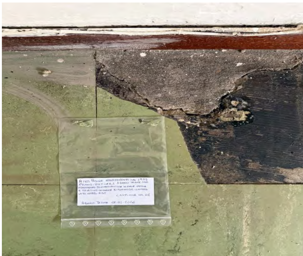
Foto 2 - campione 01 pavimentazione in vinile colore verde e collante bituminoso - camera lato nord-est
