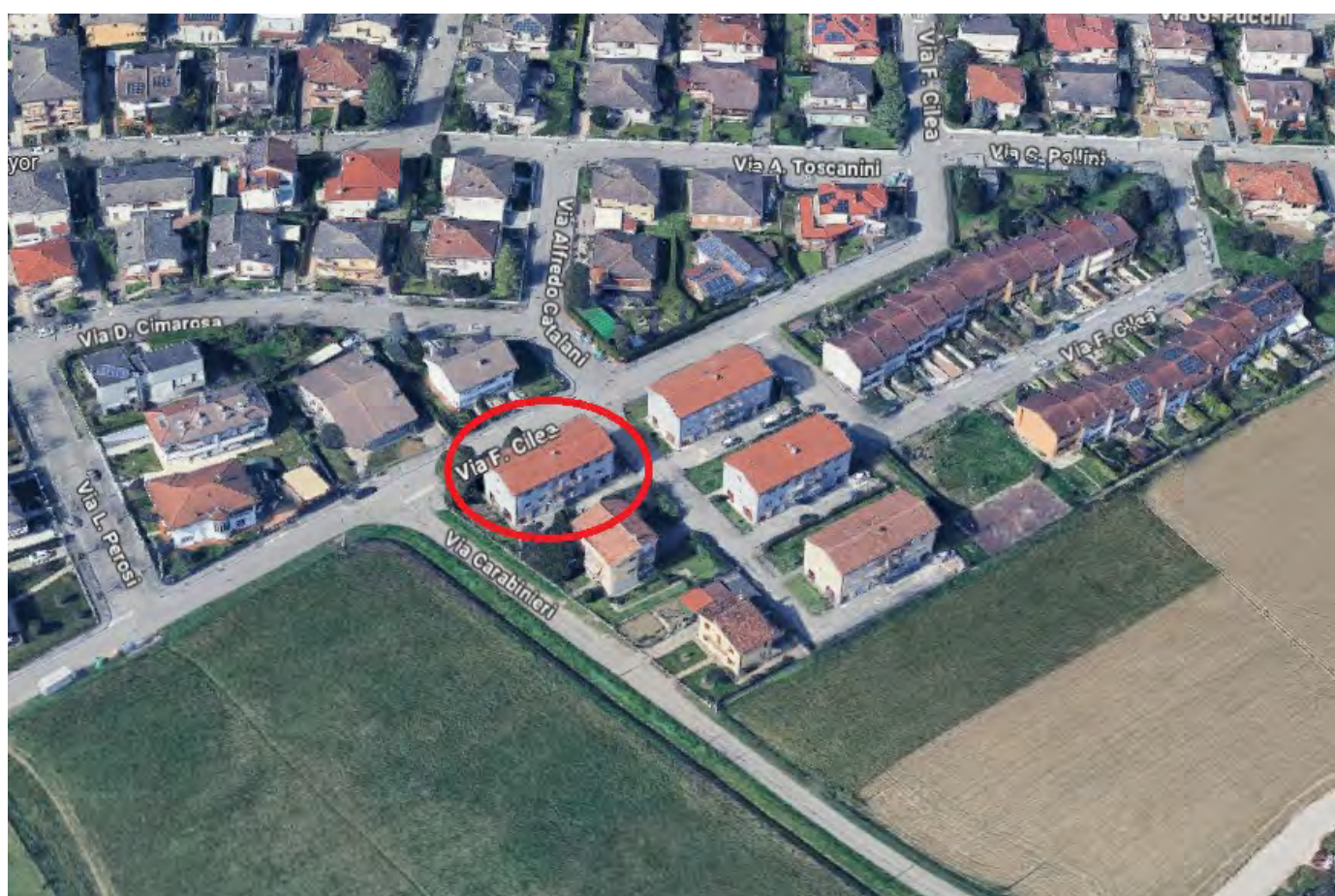
Fig. 1.3.1 – Foto aerea del sito, con individuazione del fabbricato oggetto di indagine
