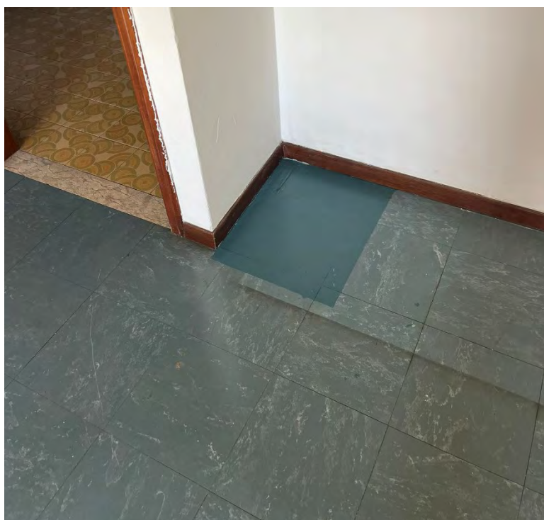
Foto 9 – vista della stanza lato ovest post incapsulamento
