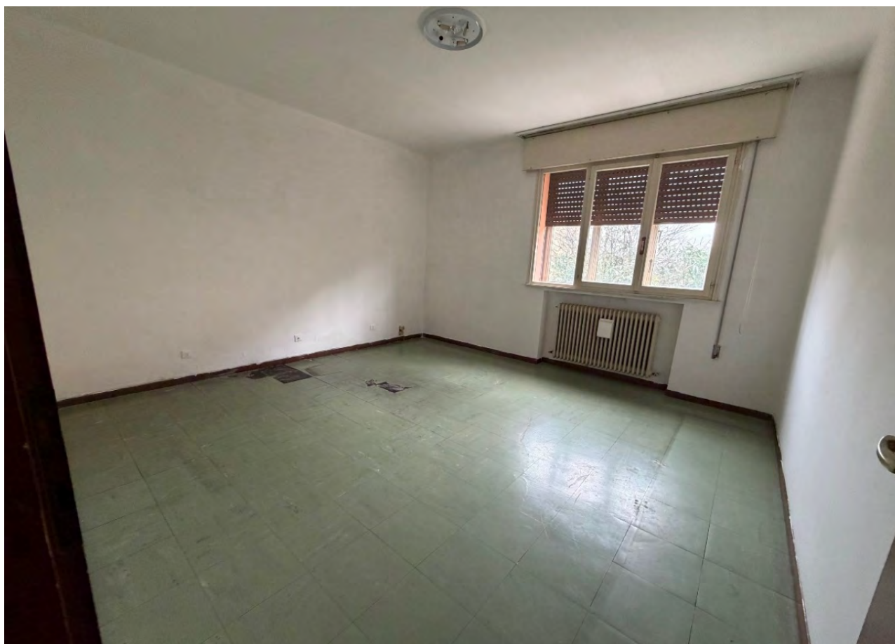
Foto 1- vista pavimento in mattonelle viniliche colore verde - camera lato nord-est
