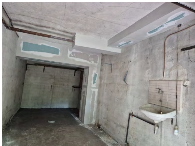
Foto 14 – vista confinamento tubazioni termotecniche garage
