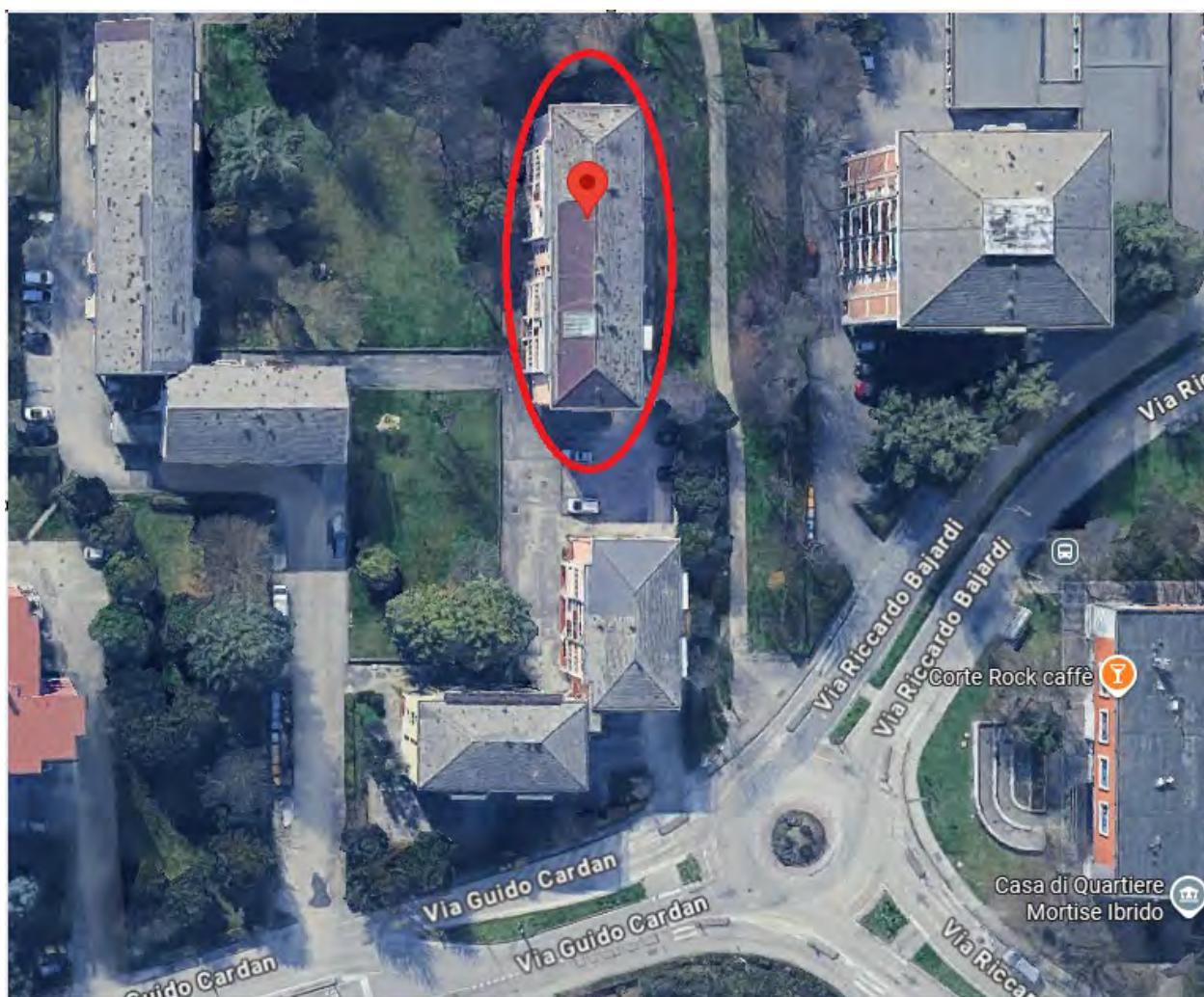
Fig. 1.3.1 – Foto aerea del sito, con individuazione del fabbricato oggetto di indagine
