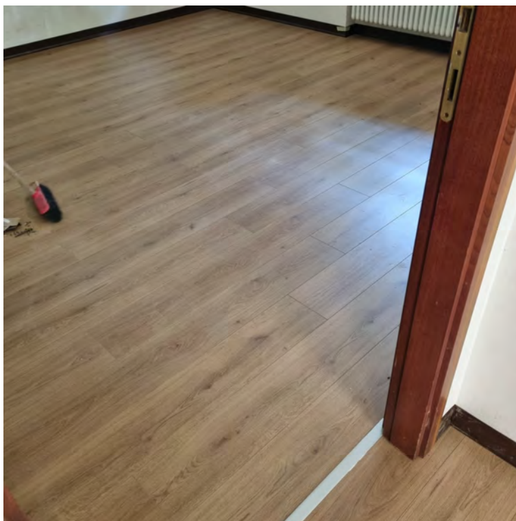
Foto 6 – vista pavimentazione stanza 01 dopo il confinamento
