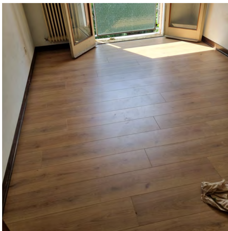
Foto 8 – vista pavimentazione stanza 03 dopo il confinamento
