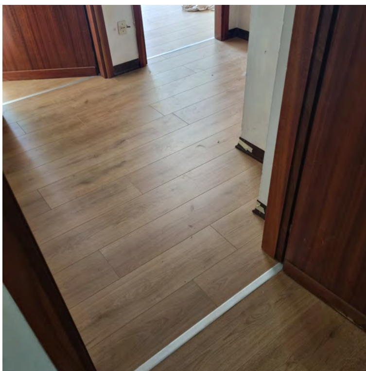
Foto 10 – vista complessiva delle pavimentazioni tre stanze e corridoio
